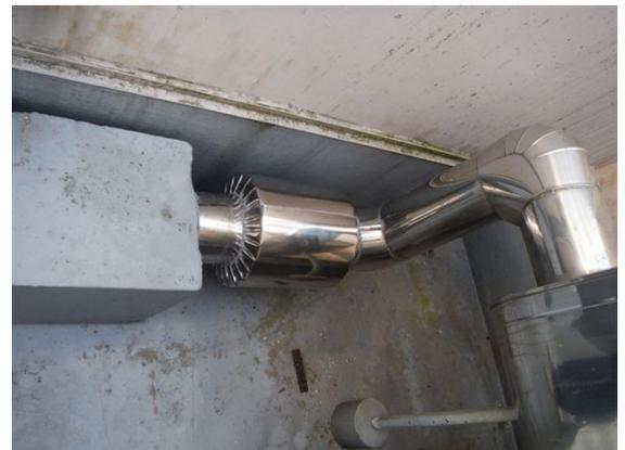
高架水槽より降下部 100A マグネタイザーM4\*3set 取付 同 断熱カバー施工
