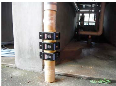
受水槽より UP 部 50A マグネタイザーM2*3set 取付 同 断熱カバー施工
