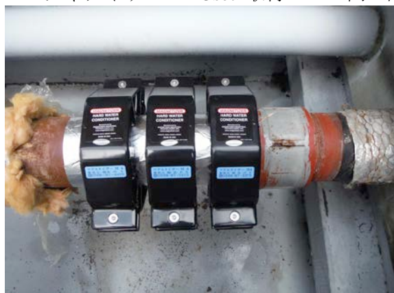
高架水槽より降下部 100A マグネタイザー M4*3set 取付 同 断熱カバー施工
