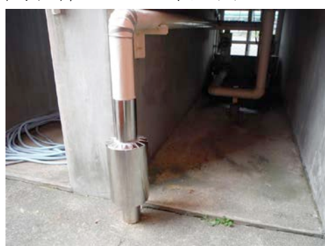
受水槽より UP 部 50A マグネタイザーM2*3set 取付 同 断熱カバー施工
