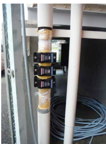
受水槽手前 市水入部 40A マグネタイザーM1-C*3set 取付 同 断熱カバー施工
