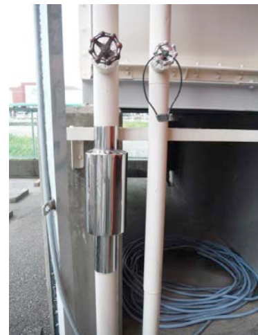
受水槽手前 市水入部 40A マグネタイザーM1-C*3set 取付 同 断熱カバー施工
