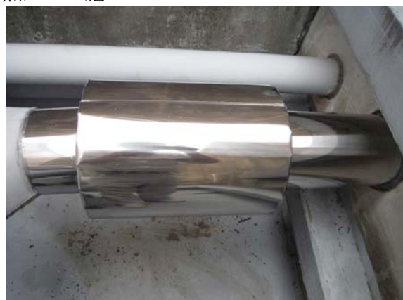
高架水槽より降下部 100A マグネタイザー M4*3set 取付 同 断熱カバー施工
