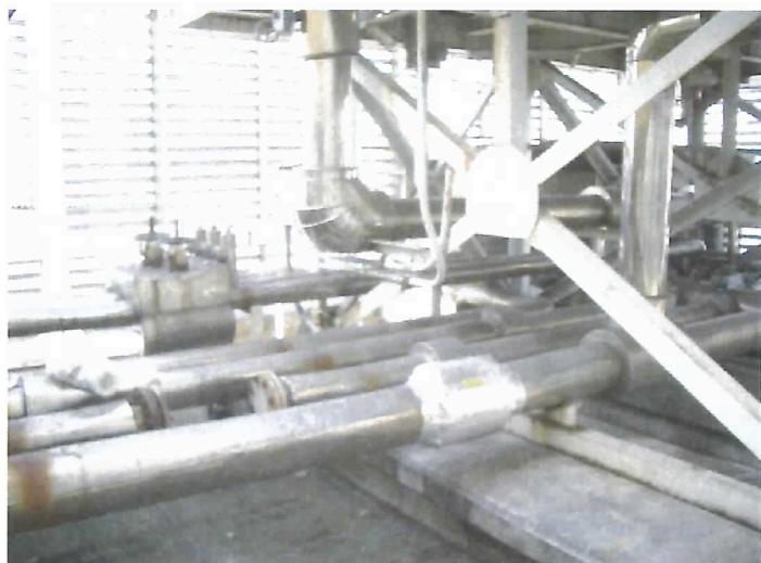
診療棟 給水管 高架水槽 in 側 100A にマグネタイザーM4*3set 診療棟 冷温水回路 150A マグネタイザーM6*3set H17.2.15 取付。赤水対策の効果実績を評価され2ヶ所にスケール除去・防錆対策・メンテ軽減で追加採用されました。
