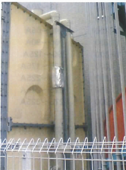
受水槽 IN 側 50A に M2*3set 取付
